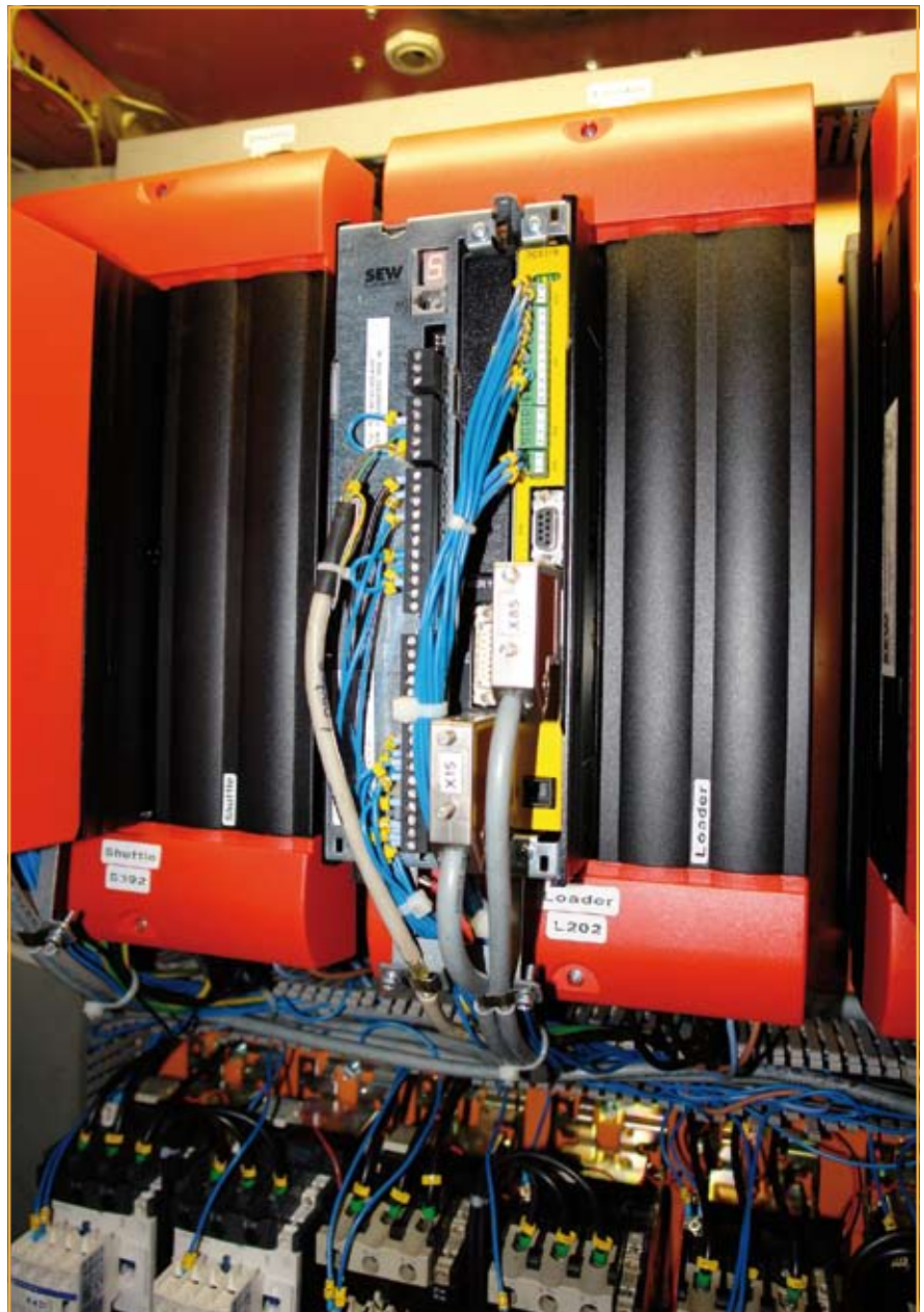
Gebroederlijk naast elkaar in de besturingskast: de Movidrive regelaars voor de shuttle en de loader; ook te zien is de Movisafe veiligheidskaart.
