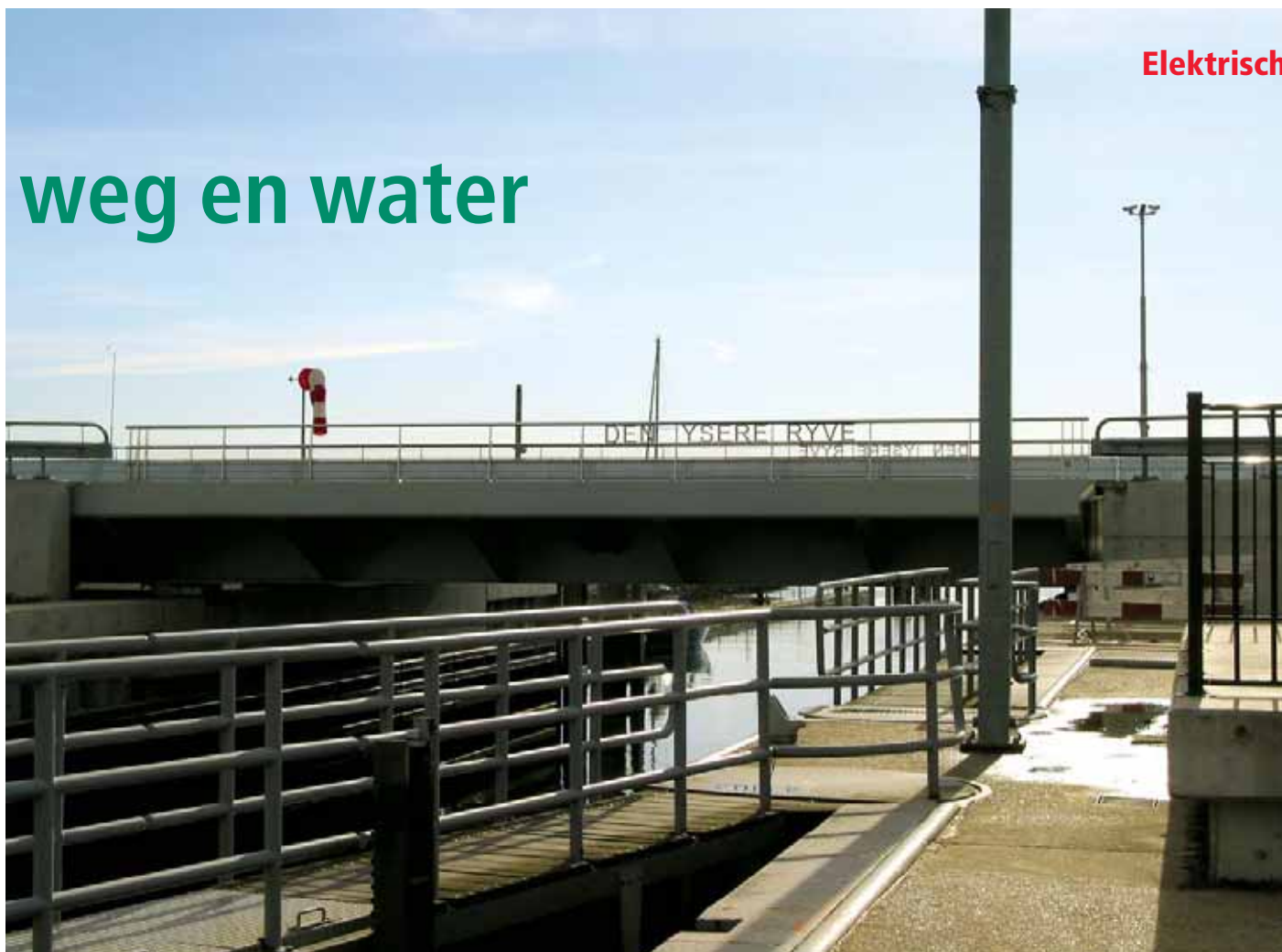
De nieuwe rolbrug van de Grevelingenluis bij Bruinisse 'den Ysere Ryve' is laag gebouwd en 'rolt' horizontaal open (foto's: Paul Quaedvlieg)
