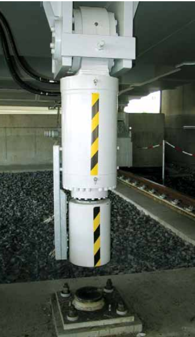
Elk van de twee hefcilinders levert een maximale drukkracht van 1900 kN om de brug 5 mm op te tillen
